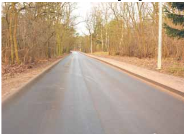
Nakładka asfaltowa na ulicy Szkolnej w Józefowie
