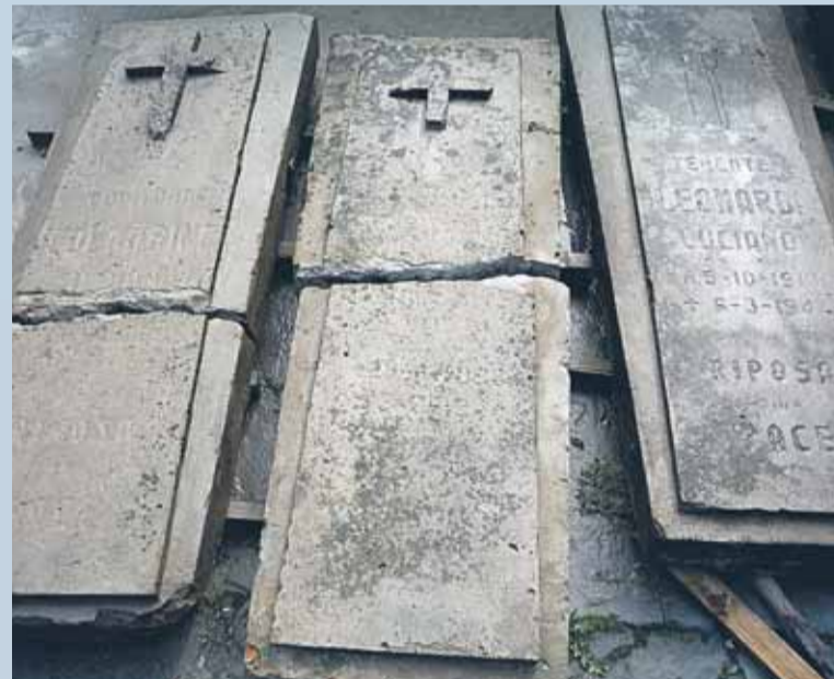
Betonowe płyty epitafijne oficerów włoskich po wstępnym oczyszczeniu (fot. autora)
