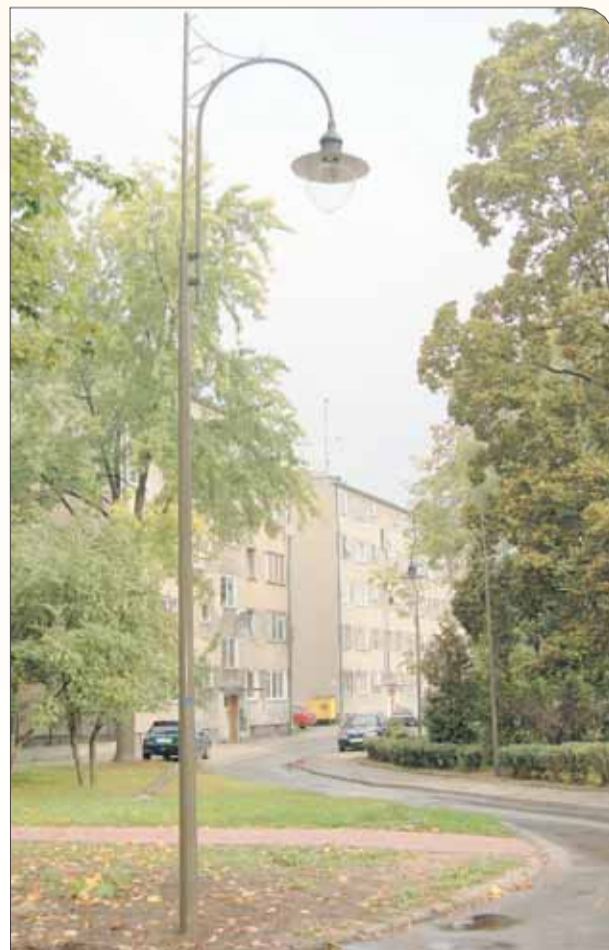
Wykonanie oświetlenia osiedla w Białobrzegach
