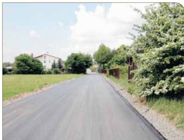
Budowa ulicy Leśnej w Wólce Radzywińskiej
