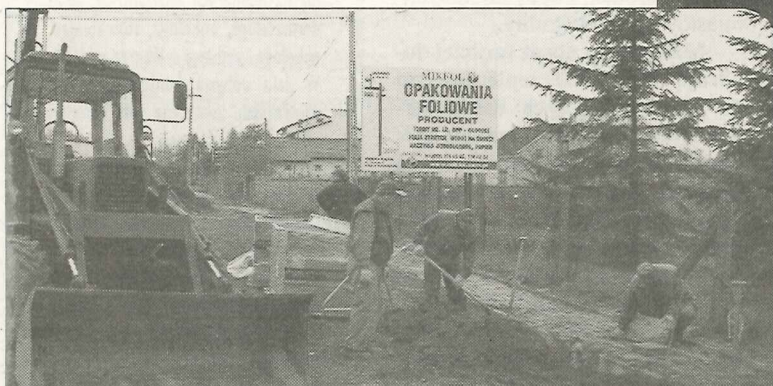
Budowa chodnika wzdłuż ulicy Warszawskiej w Michałowie Reginowie – Etap III
