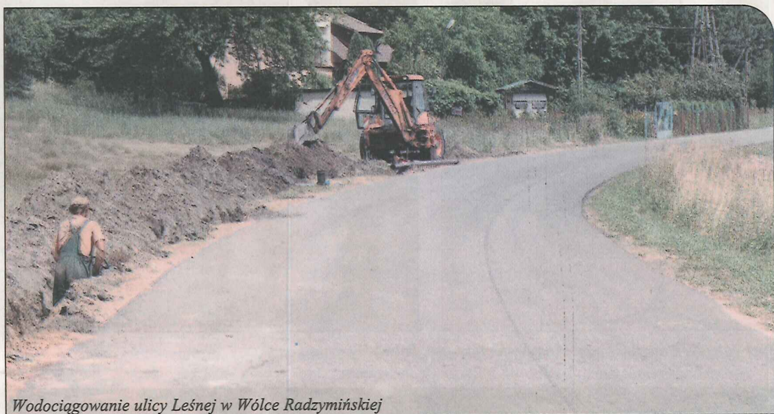
Wodociągowanie ulicy Leśnej w Wólce Radzywińskiej
