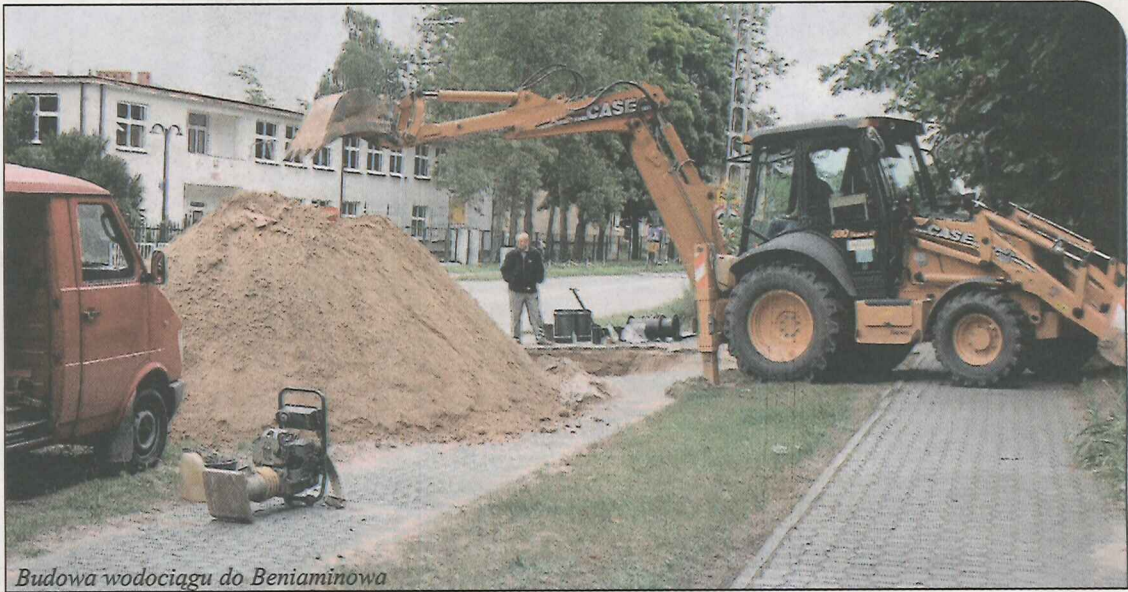
Budowa wodociągu do Benjaminowa
