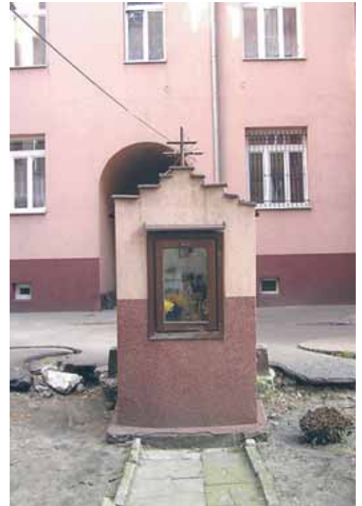
Na rogu Nieporęckiej i Białostockiej przy kamienicy nr 8 stoi stara murowana kapliczka z figurą Matki Boskiej Łaskawej
