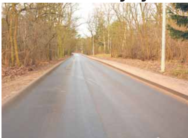
Nakładka asfaltowa na ulicy Szkolnej w Józefowie
