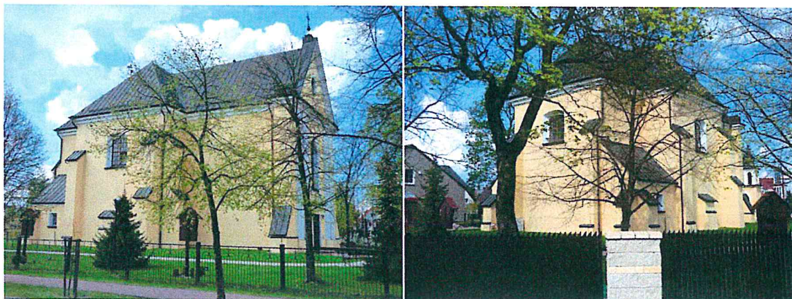
Fot. 1. Nieporęt. Kościół Niepokalanego Poczęcia NMP (źródło: Gminna Ewidencja Zabytków).
