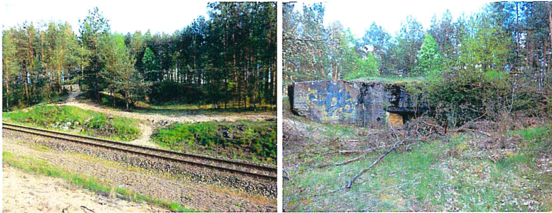
Fot. 3. Wólka Radzyńska. Bunkier (źródło: Gminna Ewidencja Zabytków).
